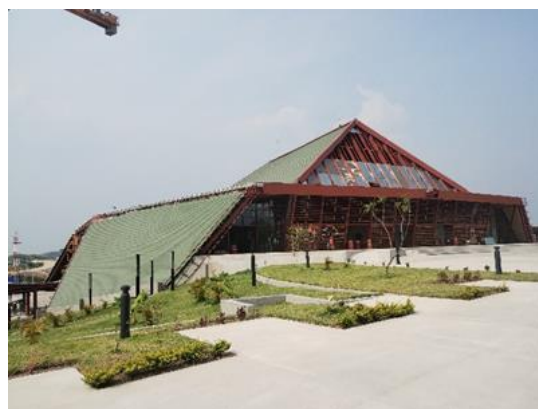
Figura 03b: Registro das instalações da primeira estação do Trem Maya na cidade de Palenque-Chiapas
